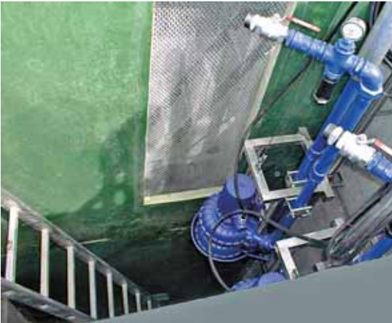
Montagevorrichtung eines Tauchmotorbelüfters zum Einbau in eine biologische Kläranlage Устройство для монтажа погружного компрессора в установку биологической очистки
